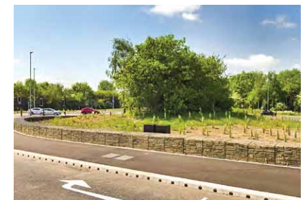
Stone Gabion Baskets (J 36)
